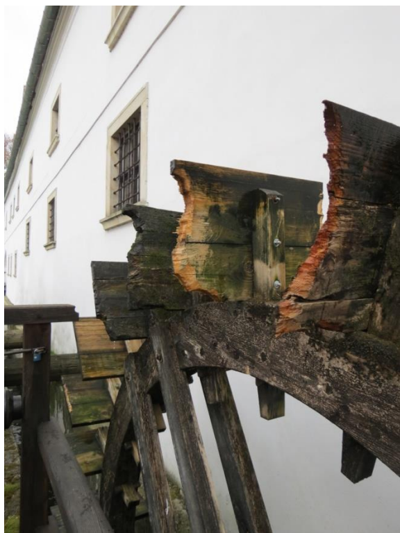
Poškozená vodní kola, 2020
