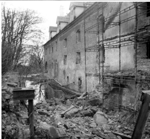
Rekonstrukce mlýna – 1977 – 1982, archiv TMB
